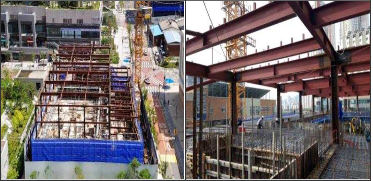
(현재 골조공사 완료 및 내부마감공사 진행 중 : 공정률 70%)
