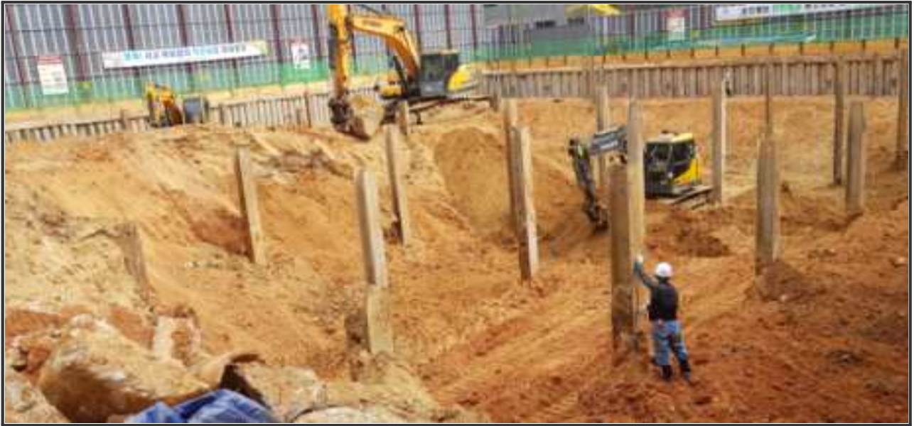
(현재 흙막이 및 터파기 공사완료 : 공정률28%)
